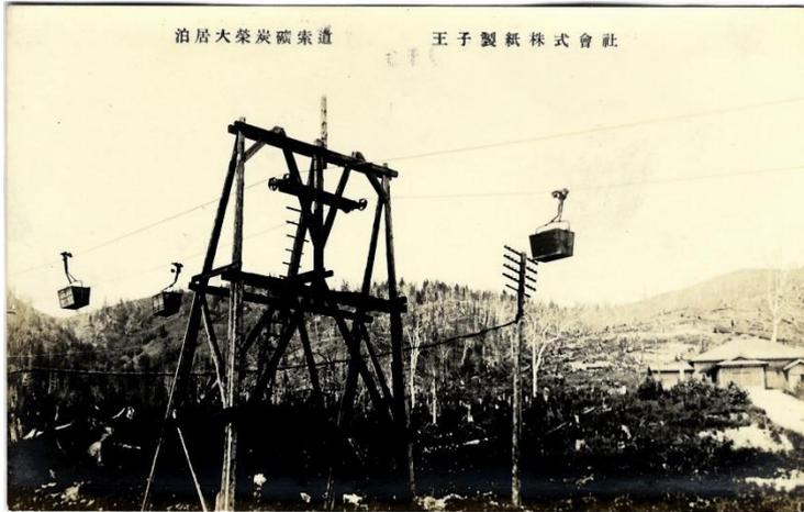
並べ替えとその後の保管。倉庫から、石炭は鉄道で会社の紙パルプ工場に運ばれました。鉄道に加えて、奥沢の石炭貯蔵所への長さ3.8kmのケーブルカーも使用されました。当初は80馬力の蒸気エンジンを搭載していましたが、1930年10月に45キロワットの電気モーターに置き換えられ、プラントは電気モーターを操作し、泊紙パルプ工場のトンネルと顔を照らすために月平均10,000kWhを受け取りました。
